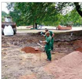
Einbau von sanoXit®-Wurzellockstoff auf der Sohle unterhalb der Wurzeln
