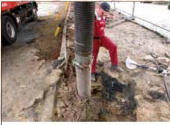
Schonende Wurzelfreilegung mittels Saugfahrzeug
