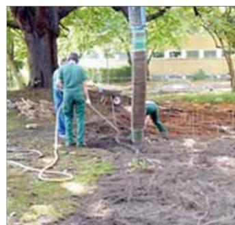
Lockerung und Absaugen des Bodens mittels Saugfahrzeug, freigelegtes Wurzelgeflecht
