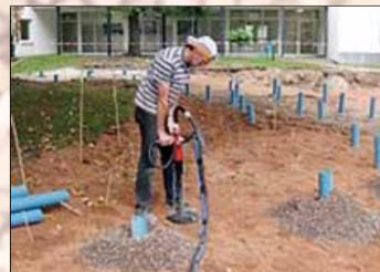
Lockern und tiefgründiges Einbringen von sanoXit®-Injektionsprodukten mittels Terra-Tree 40 Sondermaschine von MTM
