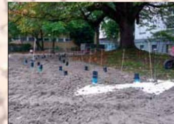
Aufgelegtes Geotextil-Vlies mit Einbau der darüber liegenden Schottertragschicht
