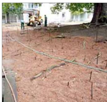
Einbetten und überbauen der Wurzeln in herbaXit®-Baumsubstrat, Typ 2a (überbaubar mit Wurzellockstoff)
