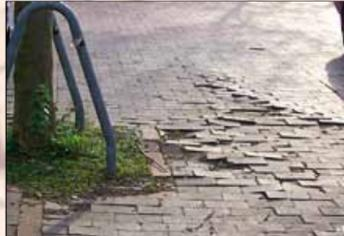
Pflasterhebung durch oberflächennahes Wurzelwachstum im Verkehrsflächenoberbau
