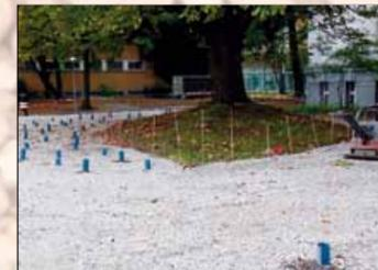
Einbau und Verdichtung der Flächenbelüftung
