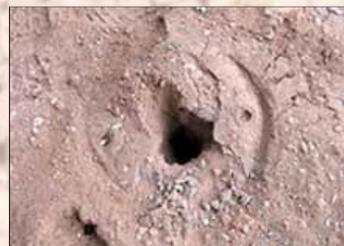
Einstich nach dem Einbringen der Injektion, Verfüllung mit sanoXit®-Fertiginjektionsmischung, Typ 1c empfohlen
